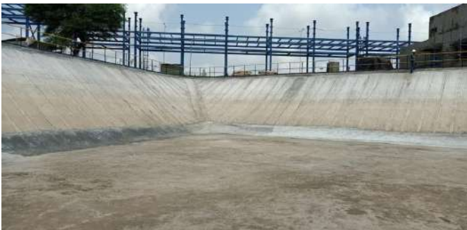
РЕМОНТ БЕТОННЫХ РЕЗЕРВУАРОВ
